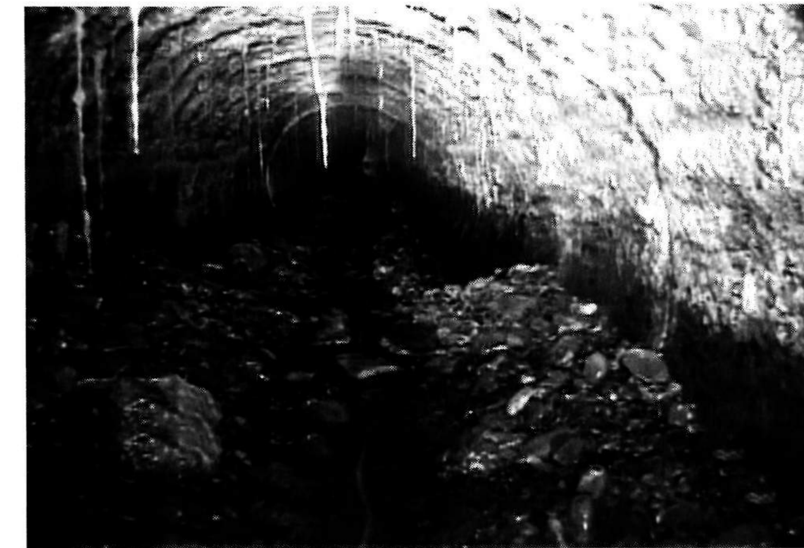
写真-6 天端の空洞部より流入した土砂・玉石の礫溜り
