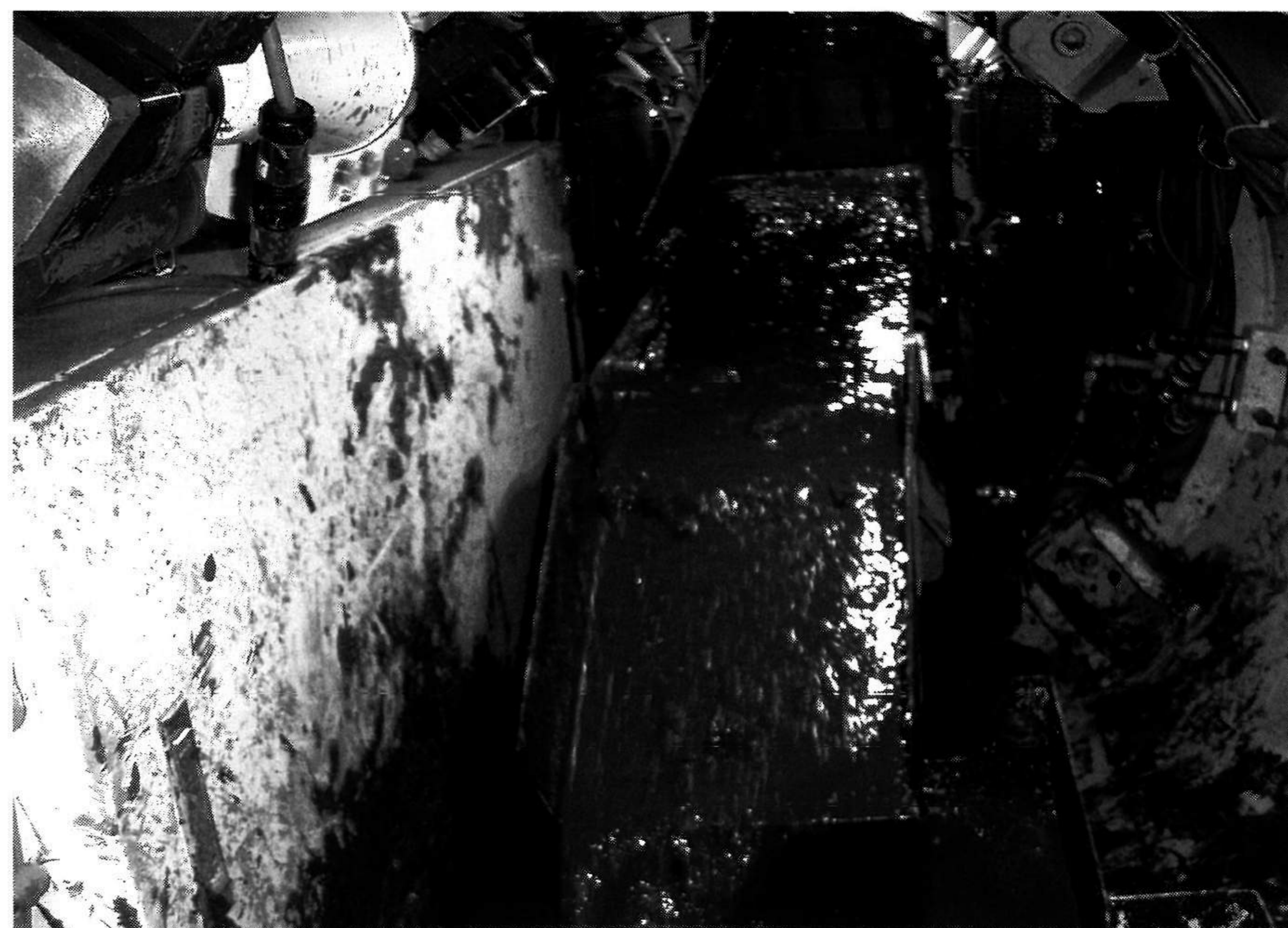
写真-4 排土状況
