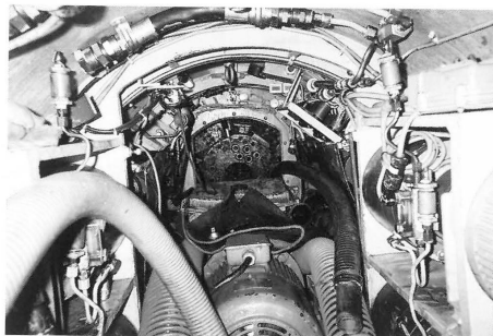
写真-5 点検扉開放状況
