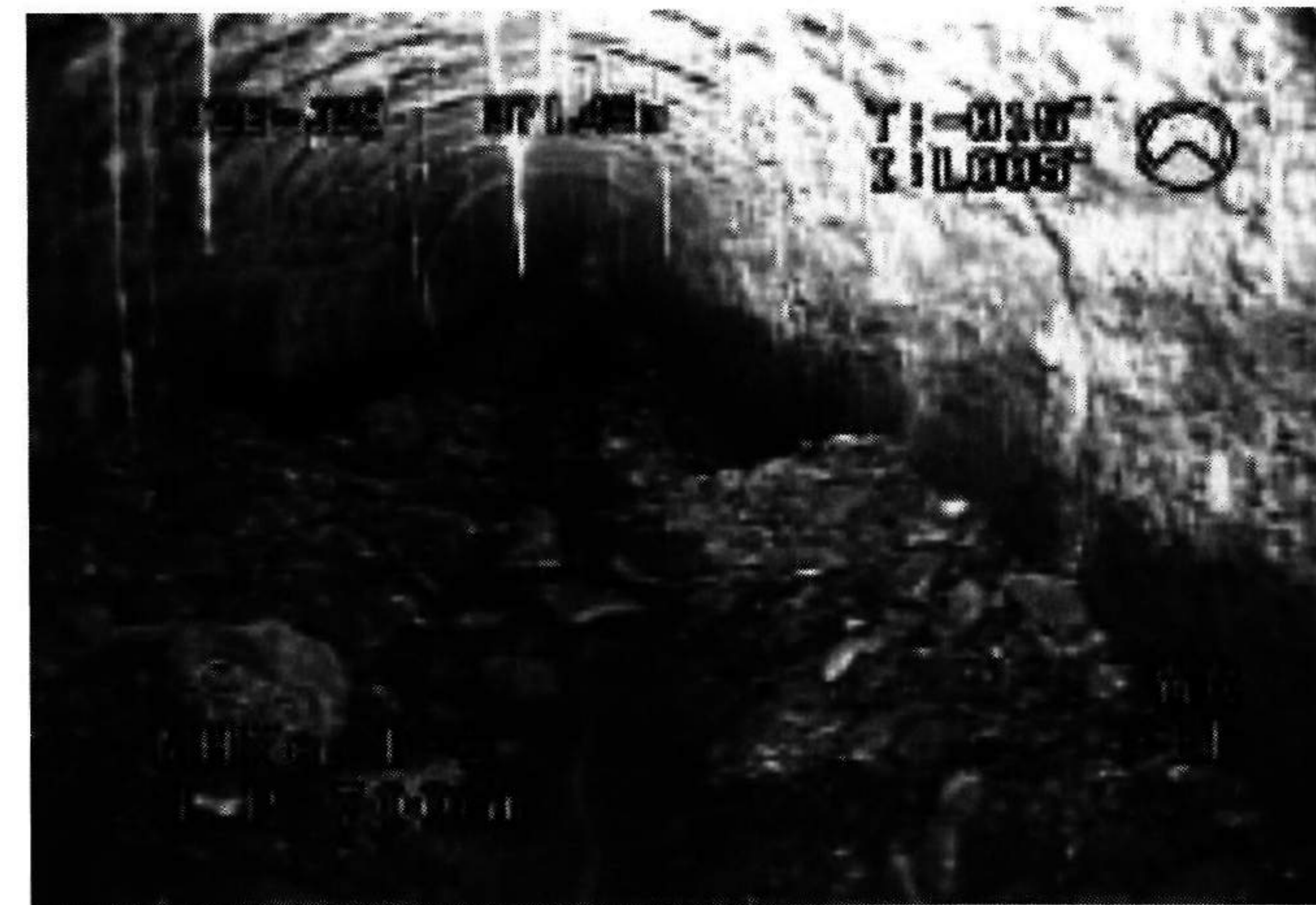
写真-1 腐食が進行した施工前の管きよ
