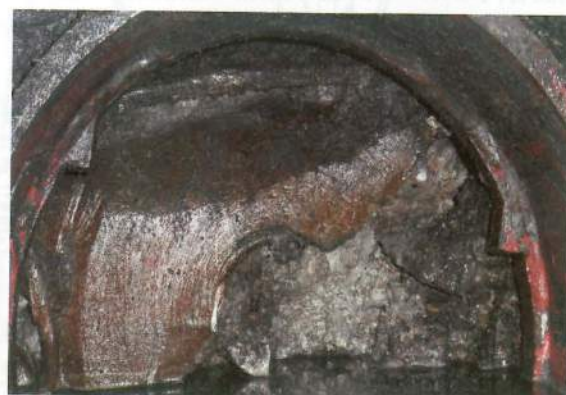
写真-9 バルクヘッド扉より切羽確認 (障害物-補修用鋼板)
