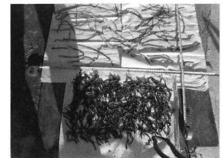
写真-5 鉄筋切断状況
