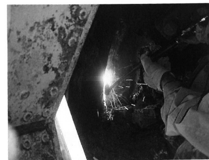
写真-3 火気切断中
