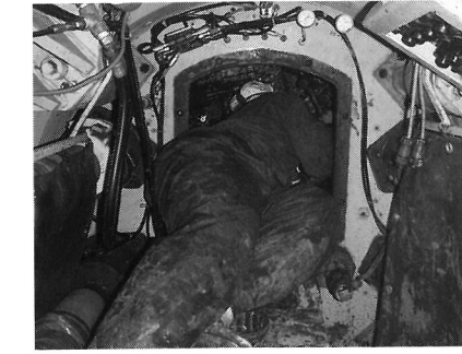
写真-9 点検扉開口、管内作業状況
