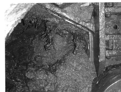
写真-7 スリット板撤去開口部拡大
