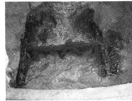
写真-4 切断完了
