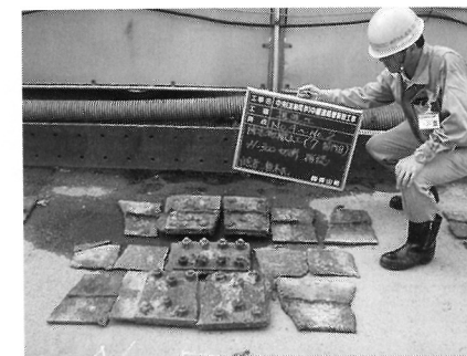
写真-5 切断片立ち会い
