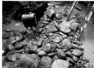
写真-8 立坑掘削状況
