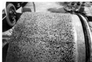
写真-11 到達した推進管外周面状況
