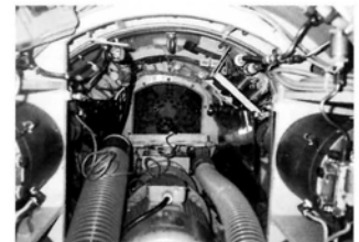
写真-10 掘進機内 点検扉からチャンバ内
