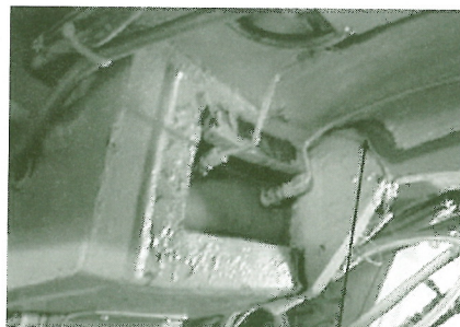
写真1 岩塊による掘進機の破損
