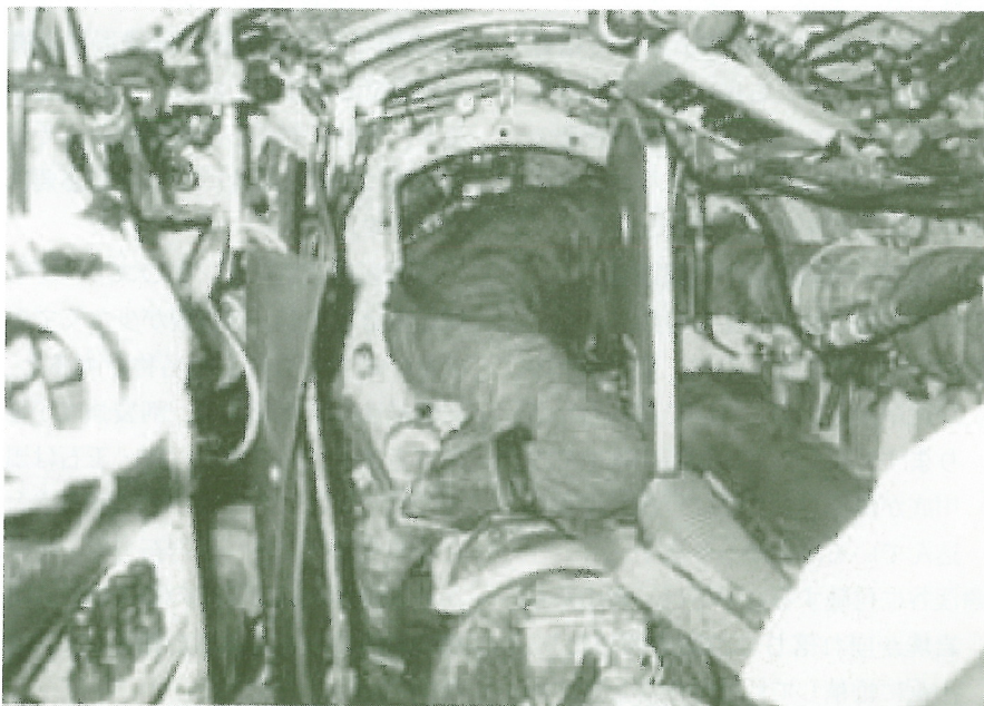
写真一六 機内からビット交換
